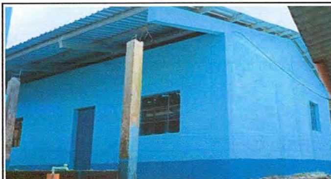
Fotografía donde se observa la finalizacion de trabajo de la reabilitacion del aula de primero primaria.
