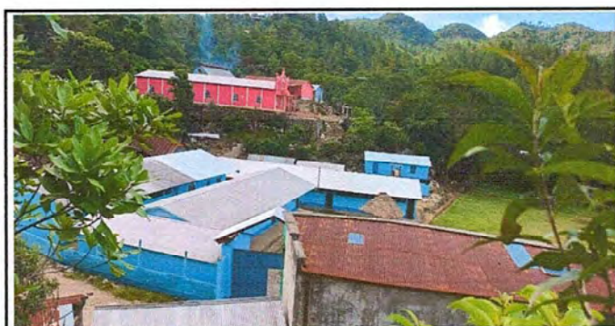
Fotografía donde se logra observar todos los trabajos finalizados con la reabilitacion del aula de primero primaria, la cocina del centro educativo y pintura del centro educativo.
