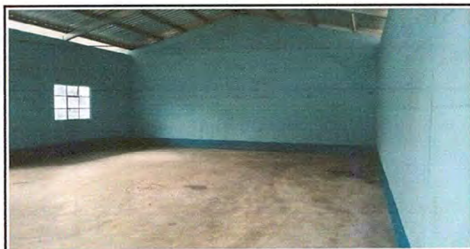
Fotografía donde se observa el piso de concreto finalizado del Aula de Primero primaria.
