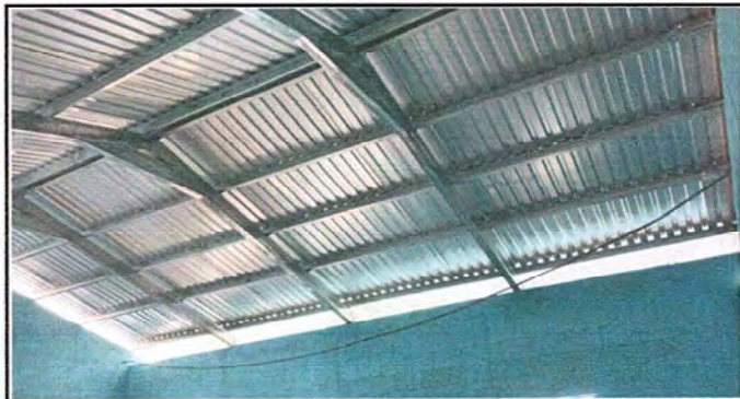
Fotografía donde se observa el cambio del entechado del aula de primero primaria.
